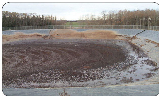
Figure 1. Structure d'entreposage en terre pourvue d'un revêtement synthétique destiné à offrir la protection nécessaire des eaux de surface et des eaux souterraines.
